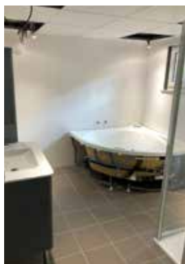
Cuarto de baño en el sótano.
